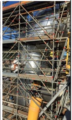
Pose de calorifuge sur tuyauterie de DN 4000
